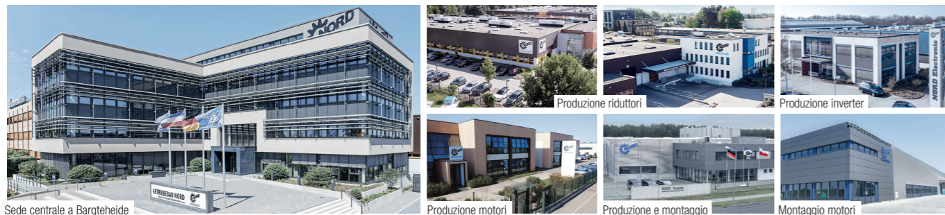
Sede centrale a Bargteheide
