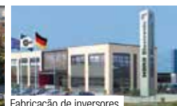
Fabricação de inversores
