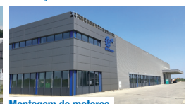
Montagem de motores
