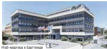
Штаб-квартира в Баргтехеде
