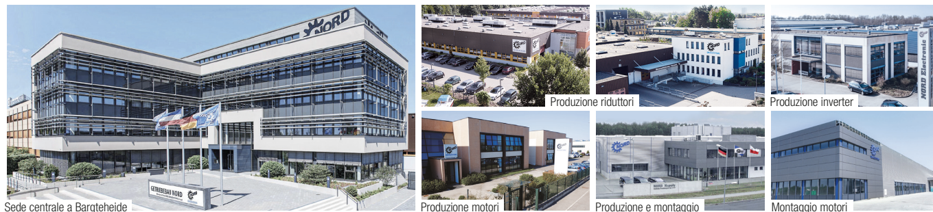
Sede centrale a Bargteheide
