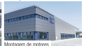
Montagem de motores
