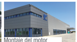
Montaje del motor
