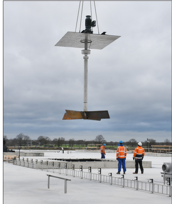
Rechts: Die Rührwerke wurden mit einem Kran auf das Dach der Vergärungsanlage gehoben.
