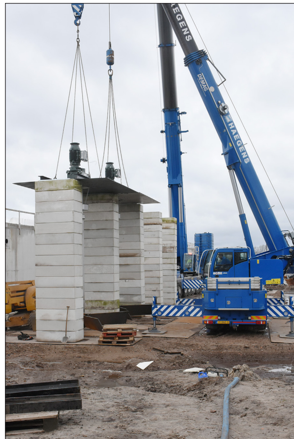
... und mit einem Kran auf das Dach gehoben.
