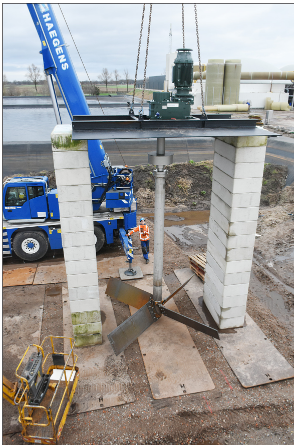
Die Rührwerke wurden vor Ort zusammengebaut...
