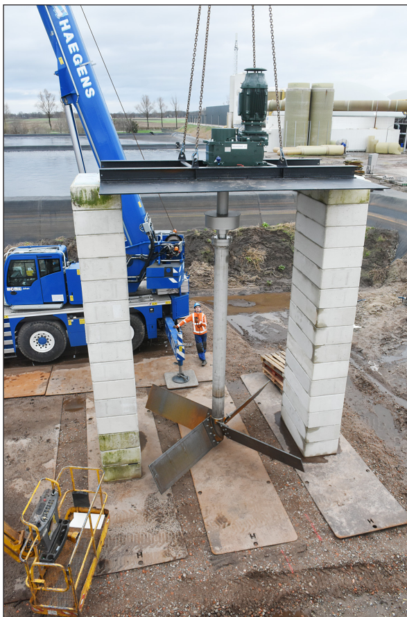
De roerwerken zijn ter plekke geassembleerd...
