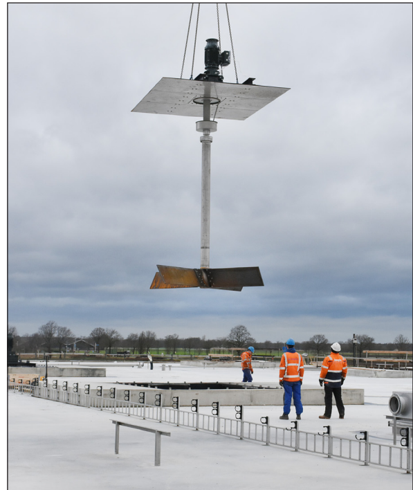
Rechts: De roerwerken worden met een kraan naar het dak van de vergistingsinstallatie getakeld.
